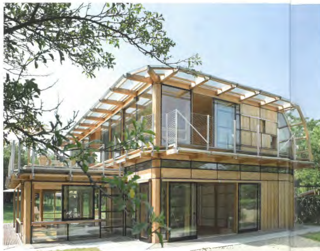
2003 errichtete man im 13. Wiener Gemeindebezirk das erste Musterhaus. 15 Jahre später ist die Grundidee der Gebäudeflexibilität noch die gleiche.
