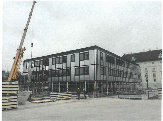
Bild 4. Montage der beiden kompakten, dreigeschossigen Holzmodul-Bürogebäude auf dem Heldenplatz mit Grundrissabmessungen von 40 m Länge und 30 m Breite – nach Fertigstellung kommen sie auf ca. 10 m Höhe. (Fotos 3 und 4: Lukas Lang Building Technologies)
