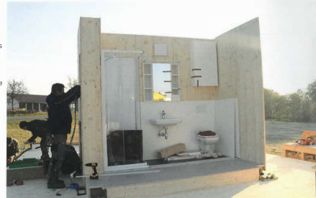
Sanitäreinheiten baut der Nachbar Appel
