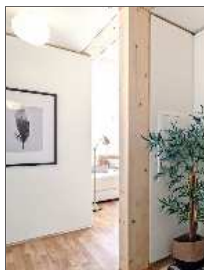
Im Innenraum bleiben die einzelnen Systemkomponenten sichtbar. An der Decke ergibt sich so ein Raster aus unbehandelten Holzoberflächen und weißen Deckenfeldern. Fotos: Sabrina Schulz (2)
