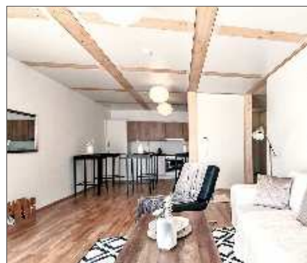
Im Innenraum bleiben die einzelnen Systemkomponenten sichtbar. An der Decke ergibt sich so ein Raster aus unbehandelten Holzoberflächen und weißen Deckenfeldern. Fotos: Sabrina Schulz (2)
